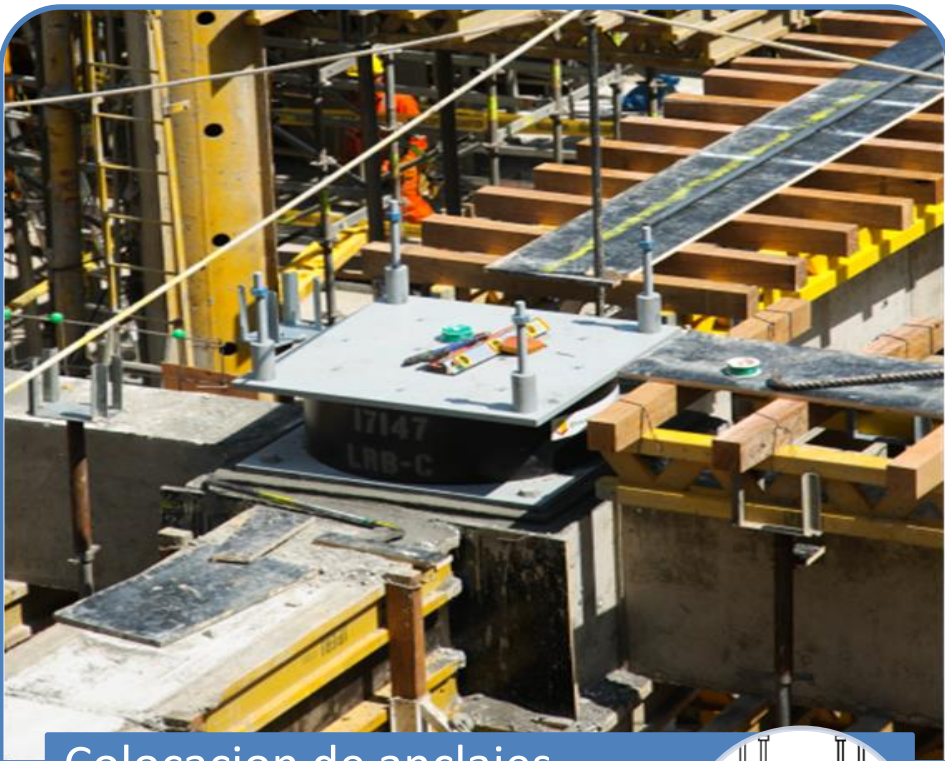
Colocacion de anclajes superiores
