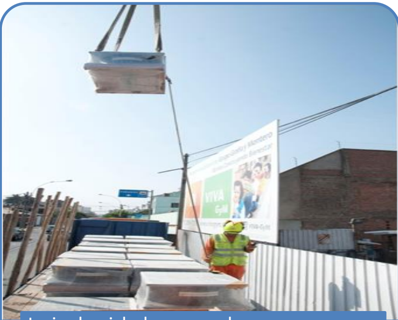
Izaje de aisladores en obra
