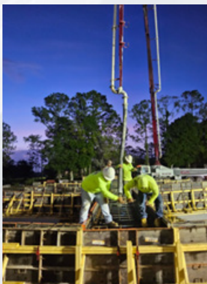
FOTOGRAFÍA DEL VACIADO DE LOS MUROS
