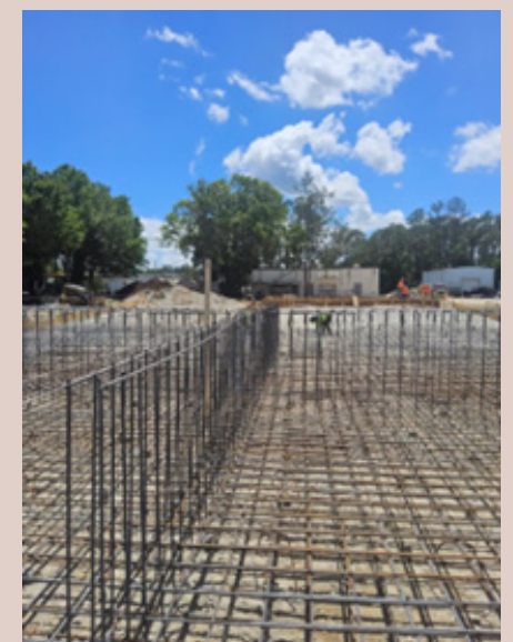
FOTOGRAFÍA DEL ARMADO DEL ACERO DE REFUERZO CON DOBLE MALLA
